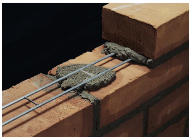
Så här lägger man Brictec Murverksarmering på bruksklickar för att armeringen skall hamna mitt i liggfogen.
